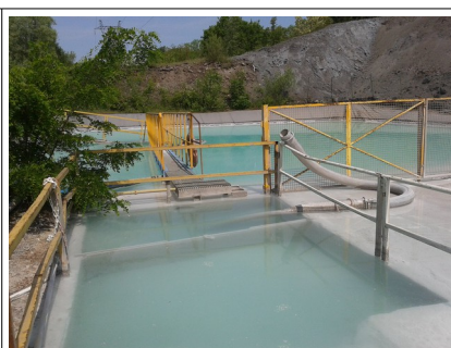
Bassin de récupération des eaux pluviales en situation de débordement
