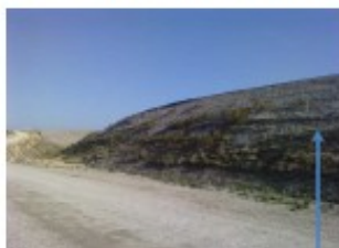
Diguettes de séparation (1)
